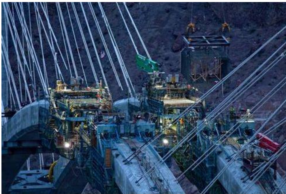
Extrem sorgfältige Arbeit ist nötig bis zuletzt! (c) Jamey Stillings Photography
